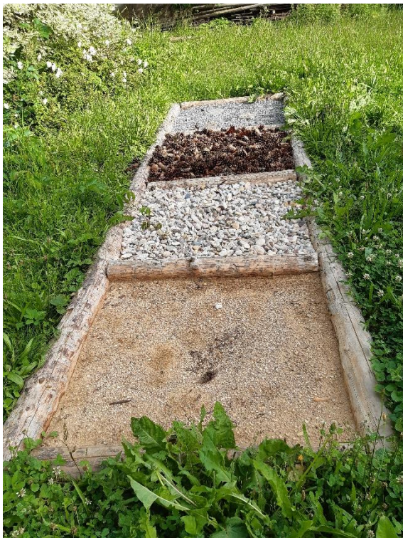
Obnova hmatového chodníku
